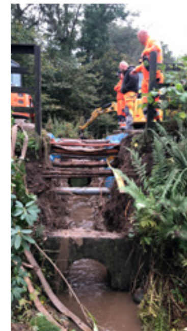
Udskiftning af beton i åløbet.
